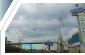
DEKOCITY ÜSTGEÇİT ELEKTRİK İŞLERİ (ESKİŞEHİR YOLU) ANKARA BÜYÜKŞEHİR BELEDİYESİ
