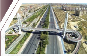
MTA ÜSTGEÇİT ELEKTRİK İŞLERİ
